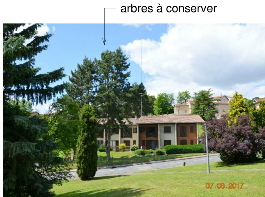
Vue 13 Façade Sud-Est
