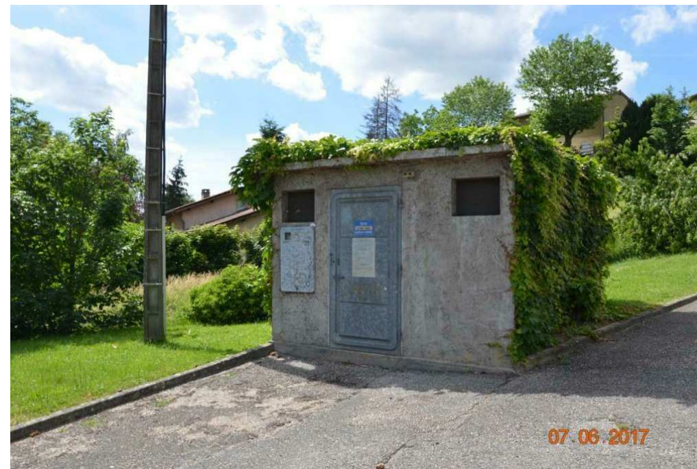
Vue 8 Transformateur EDF conservé entre chemin communal et parking résidence GLH
