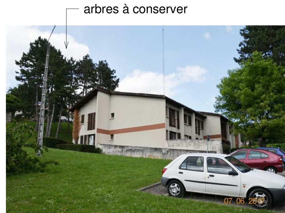
Vue 14 Façade Ouest
