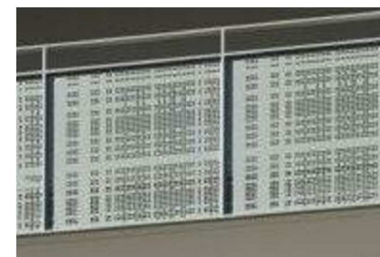
Détail garde-corps des balcons en tôle perforé type Gantois Rythmic ATHOS laqué en RAL 7009 (gris vert)
